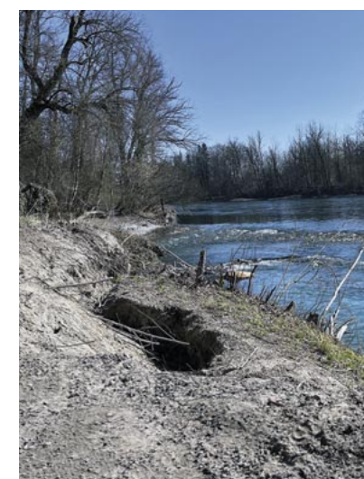
Teile des Uferwegs drohen abzurutschen oder sind bereits von der Erosion weggeschwemmt worden.
