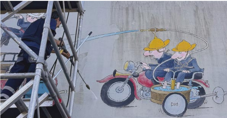
Vorher – Nachher. Mitarbeiter der Reimal AG in Gümligen reinigten die Wand mit einem Hochdruckreiniger. Über die Jahre hat sich eine hartnäckige Schmutzschicht gebildet. Die Reinigung der Wand hat mehrere Stunden gedauert. Auf dem Bild ist der Unterschied vor und nach der Reinigung gut zu erkennen.
