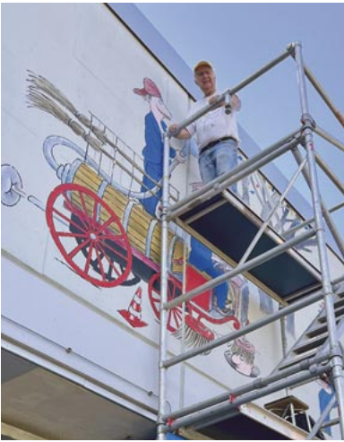
Arbeiten in luftiger Höhe! Das Arbeitsgerüst auf dem Oskar Weiss während der Restauration des Wandbildes steht, ist rund acht Meter hoch. «Eigentlich bin ich nicht ganz schwindelfrei», lacht Weiss. Trotzdem macht die Arbeit dem inzwischen 82-jährigen grosse Freude.
